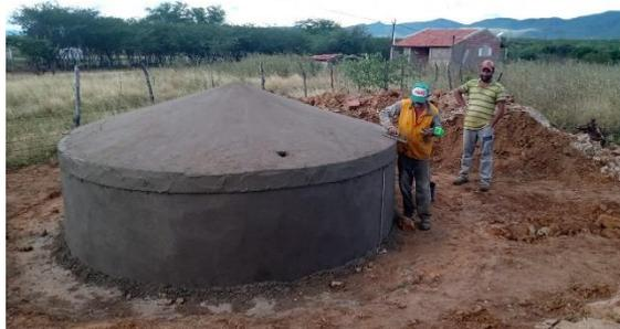
**Foto 23: Acabamento/reboco da cisterna**
