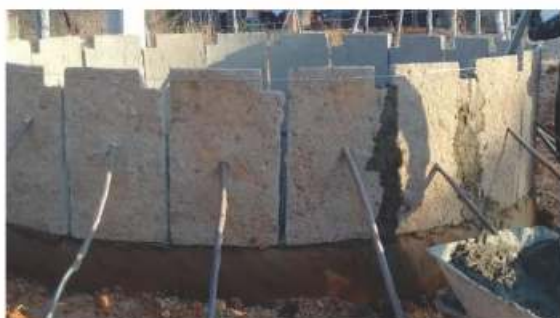
Foto 19: Montagem das paredes
