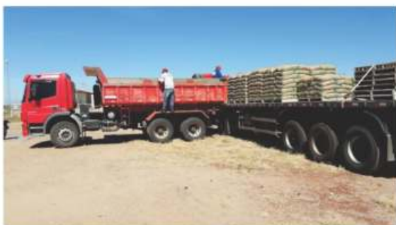
Foto 13: Distribuição do cimento
