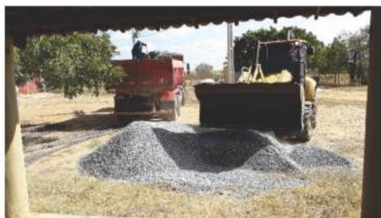
Foto 14: Distribuição da brita
