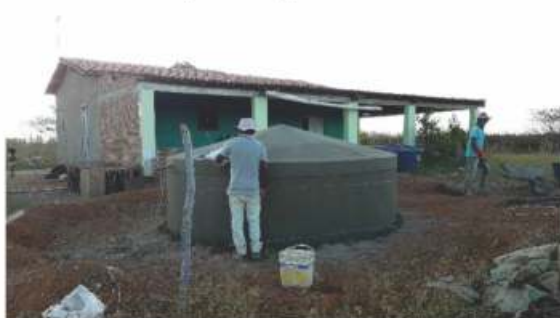
Foto 21: Acabamento/reboco da cisterna
