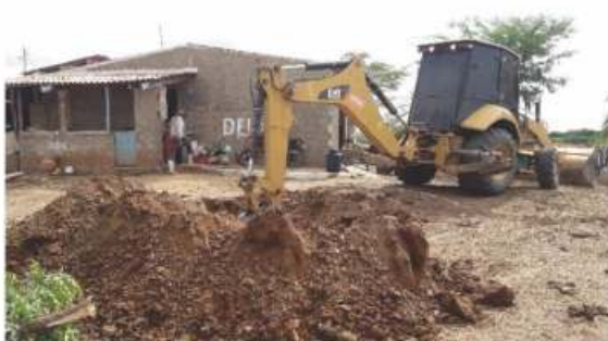
Foto 11: Escavação do buraco da cisterna
