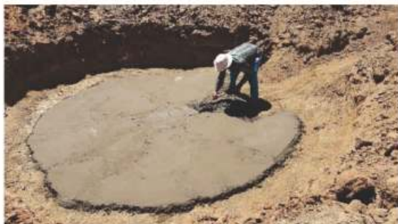
Foto 17: Construção do piso
