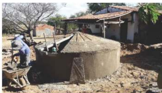
Foto 20: Montagem da cobertura
